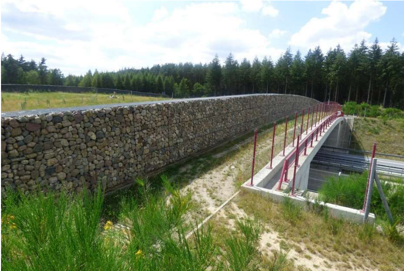
Abb. 4: Weg am nördlichen Rand über die GB Wredenhagen; Abgrenzung durch eine mehr als 2 m hohe Gabione
