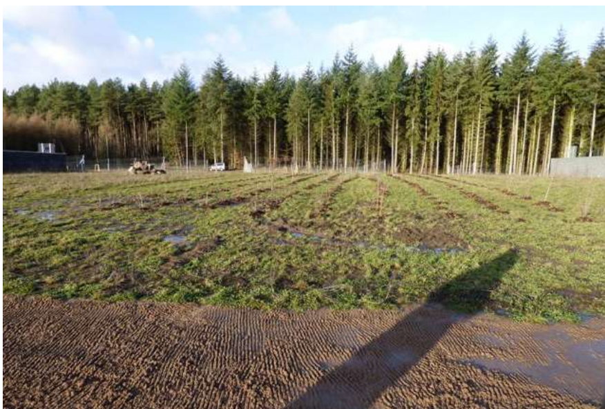
Abb. 24: starke Vernässung nach Frost auf der Grünbrücke (Zustand 28.01.2016)
