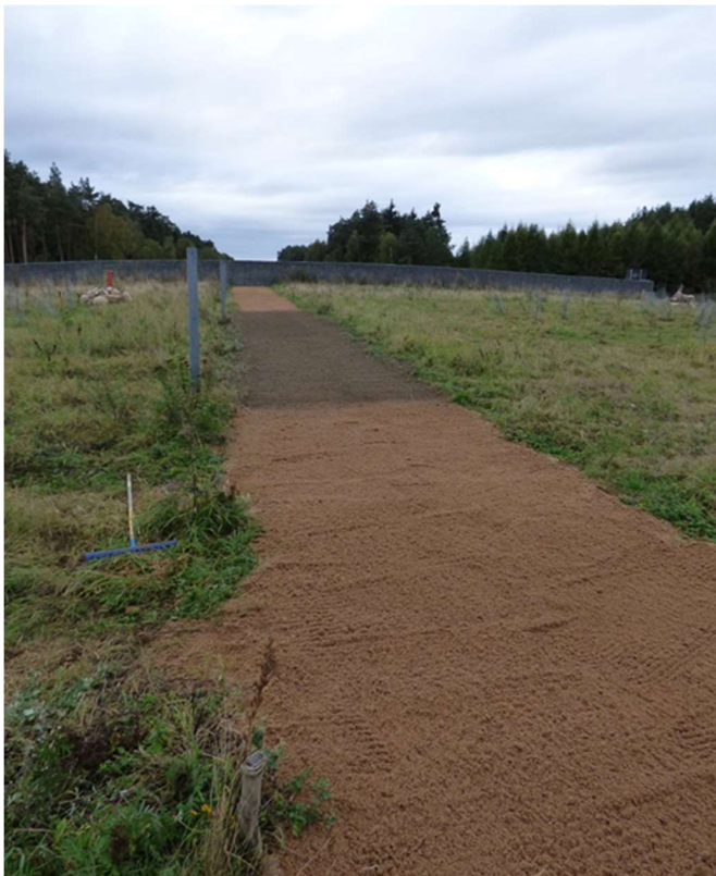
Abb. 11: aufgebrachtes bindiges Material (dunkel gefärbt) auf einer Länge von etwa 10 m (Sommer 2016)
