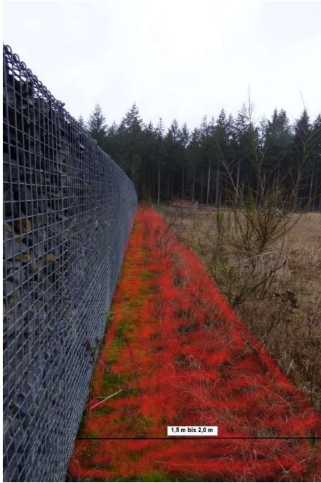
Abb. 55: Pflegestreifen entlang der Gabione, jährliche Mahd notwendig
